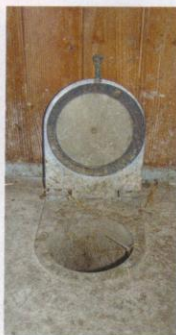
In den Boxen befinden sich Misteinwurfschächte (l.). Bei Betrieb öffnen sich die Luken (M.) und der Mist wird von einem Staubsauger bis zum Misthaufen geblasen (r.).
